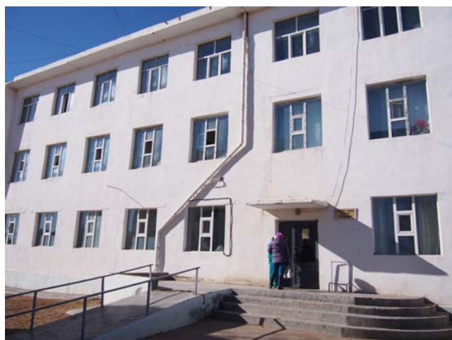
写真 6 県立病院入院病棟
