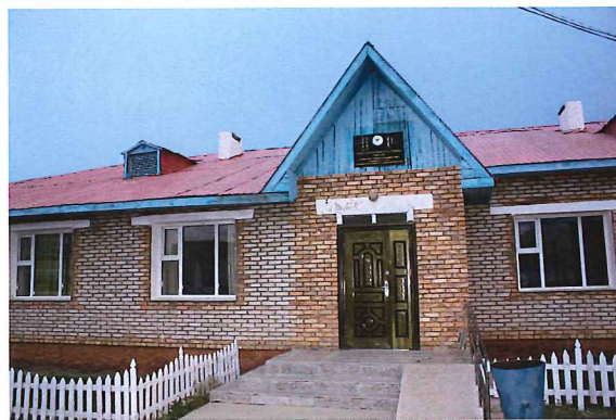
写真3 バヤンホンゴル県ジャガラントソム病院
